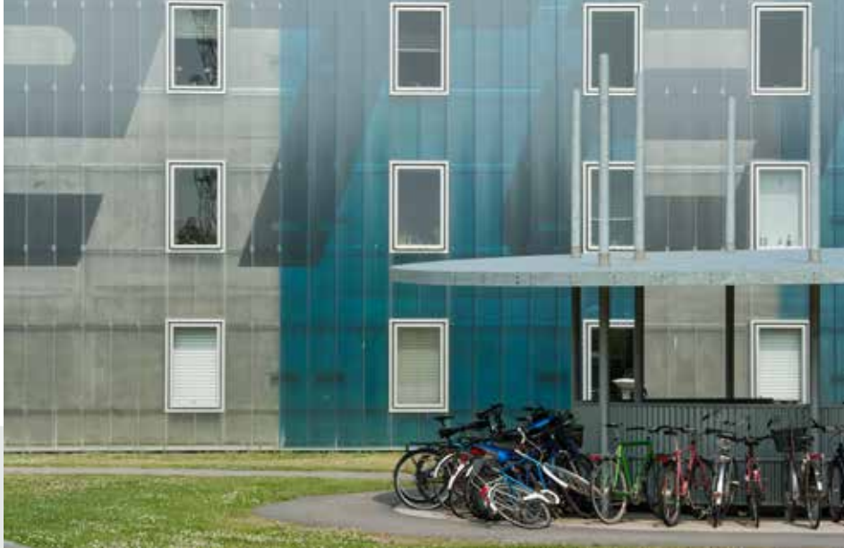
Alpha-Beta-Kollegierne, Viborg. Facadebeklædning af polykarbonatplader op-hængt på alu-skelet.
